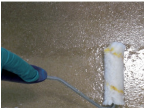
"Terrazzo alla veneziana" effect. Application of Mapefloor I 910
