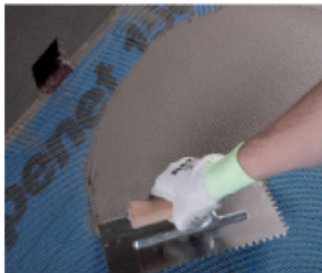
Laying Mapelastic on Mapenet 150
